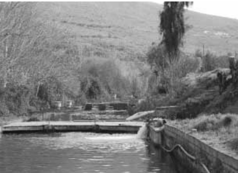
Vista de la piscifactoría, con sistemas de lagunajes de regeneración de flora y fauna y efectos de humedal
