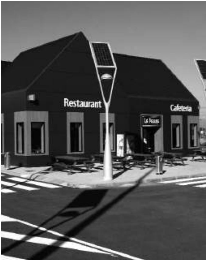
Una de las farolas instaladas en Montcada
