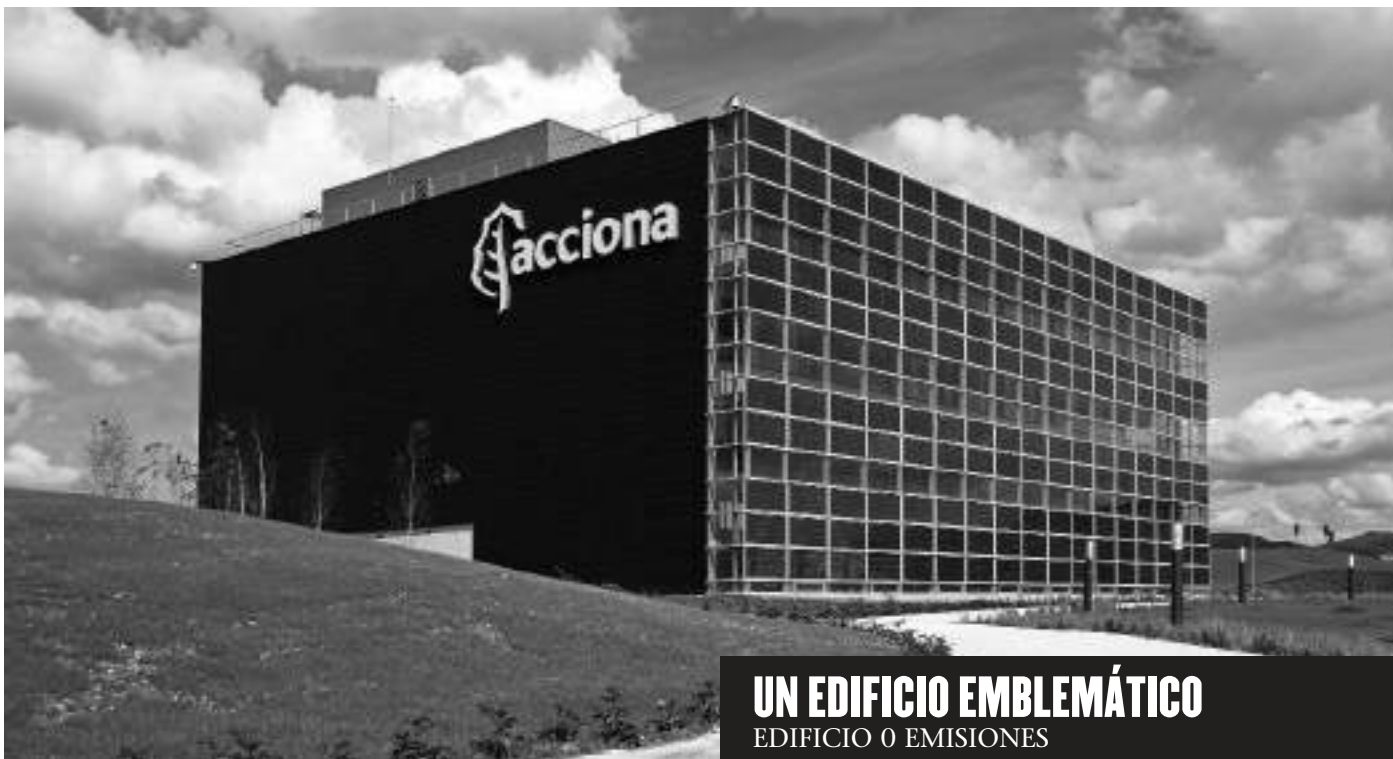
FOTO: El edificio ACCIONA lleva el significativo nombre de Emisiones 0
