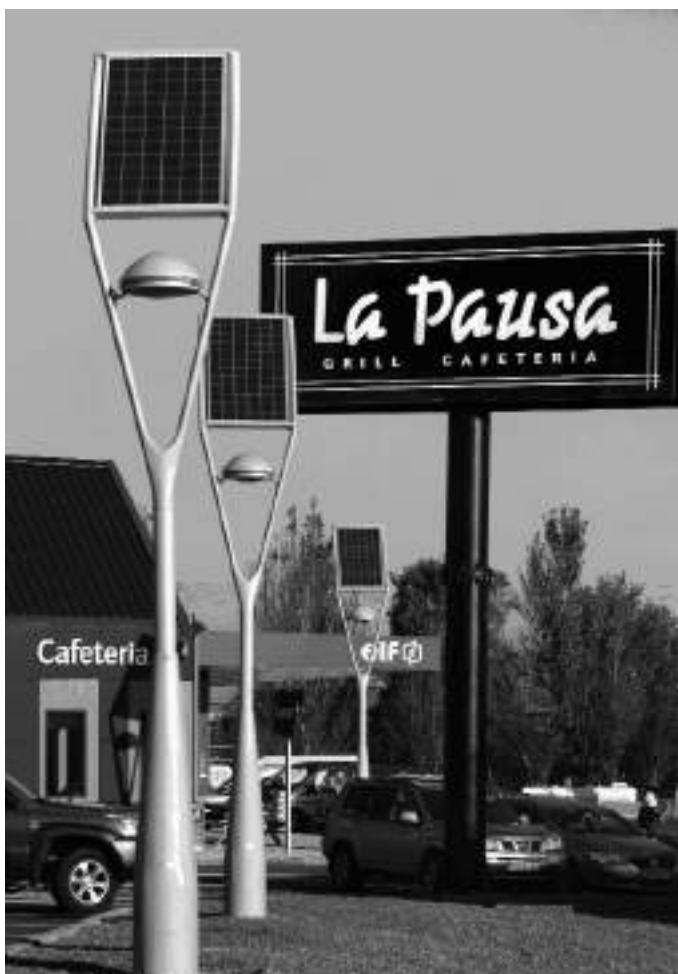
Las farolas solares tienen que estar orientadas al Sur y bien ancladas
